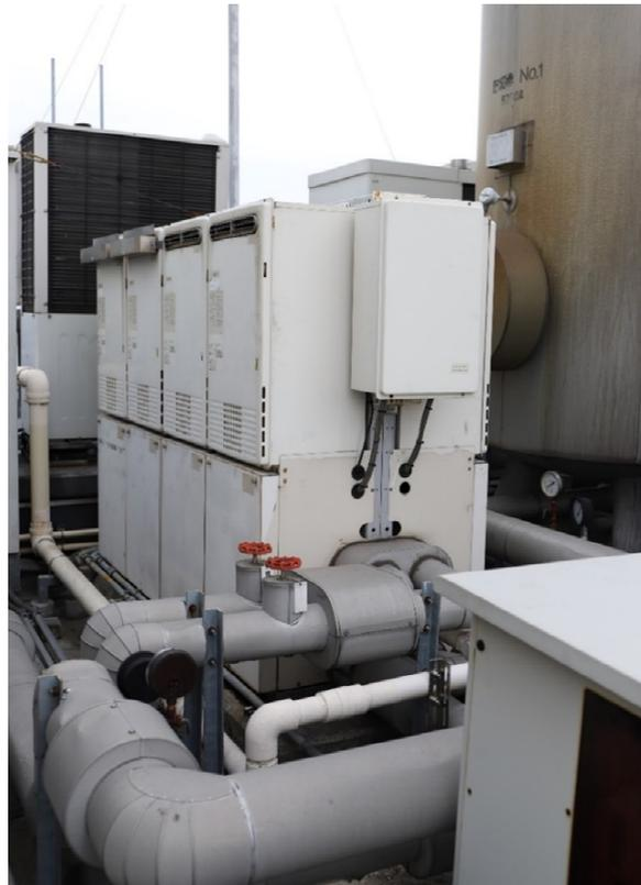
写真 2.5.1 熱源回りの配管写真の一例
