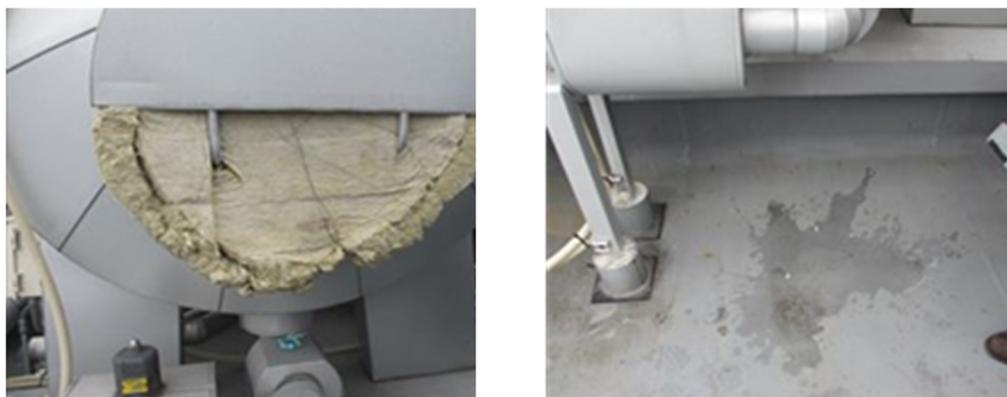
図 2.5.7 貯湯槽マンホールの断熱材(左)と流れ落ちた水(右)<sup>5)</sup>
