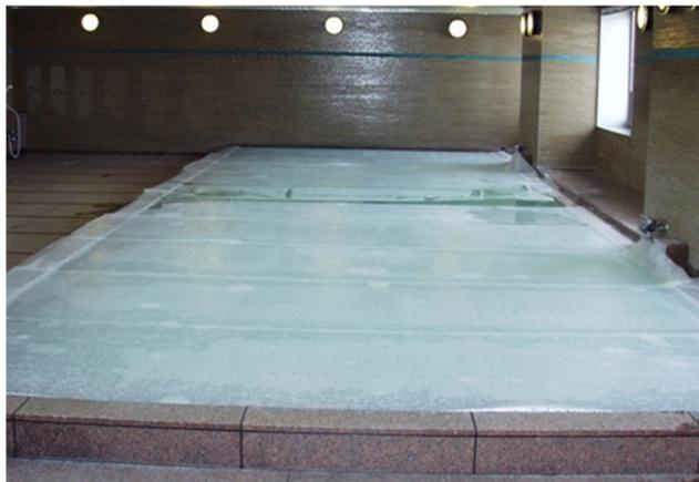
図 5.4.1 シートによる放熱量の削減
