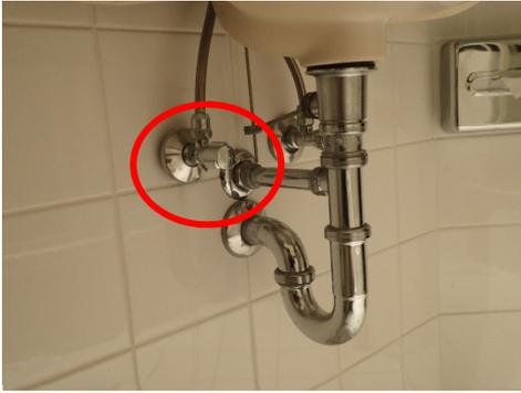
写真 2.6.1 洗面器・手洗器本体下部のアンクル
